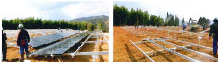
さらに10基を設置(49.36kW×3基、49.72kW×7基)。設置工事が着々と進んでいた(平成26年1月20日)。
