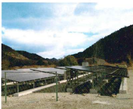
2号機。先に設置した1号機は写真左手奥に。
